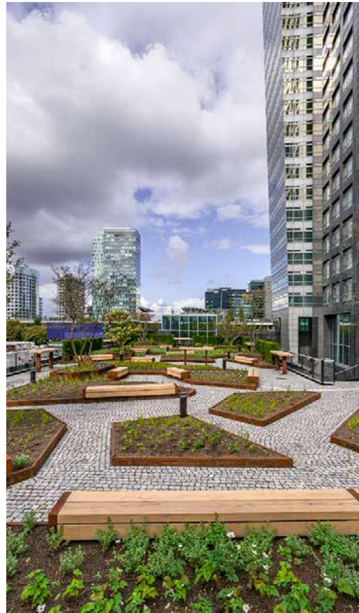
Het groene dak van Circl: niet alleen een prettige verblijfplaats, maar ook waterberging. Geheel uitgevoerd met hergebruikte elementen en materialen. Ontwerp en uitvoering door Donkergroen.
